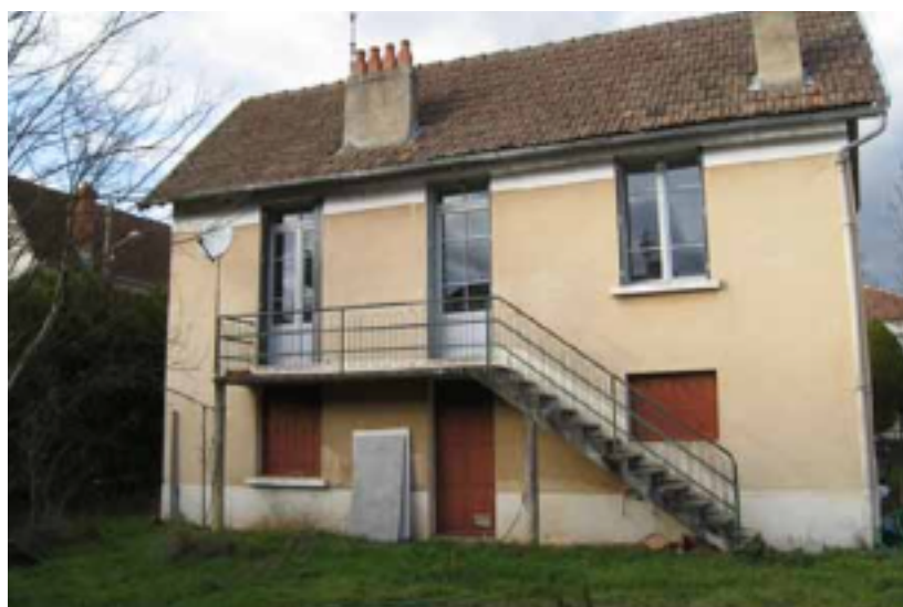
Figure 13 : Étude de cas : rénovation d'une maison pavillonnaire à Cahors
